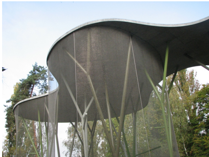
Abb. 6.1 Dach der Volière Bois-de-la-Bâtie in Genf, bewehrt mit Top12 Stahl
